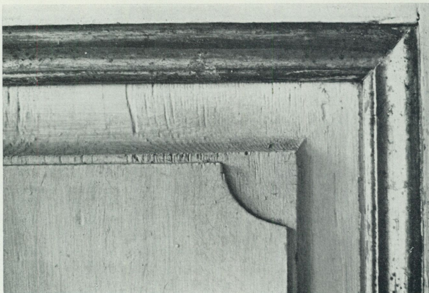
26. Detalj av en pärlgrå och förgylld panel, uppsatt och målad 1793 i Sko- gaholms herrgård. De ospacklade trä- ytorna syns tydligt genom det tunna oljefärgslagret.
