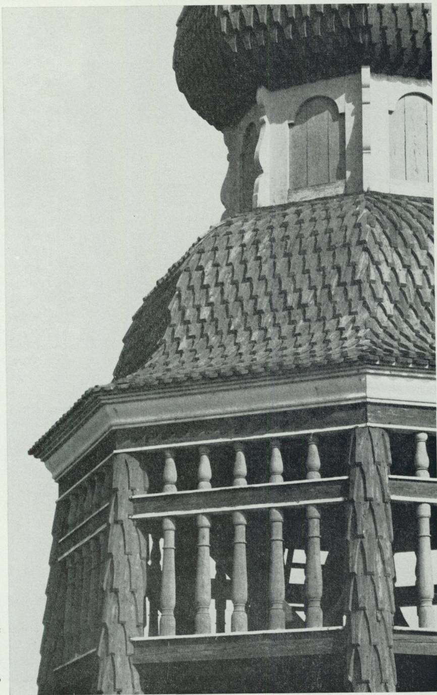
3. Håsjöstapeln på Skansen är klädd med spån. Att täcka en sådan yta kan nästan jämföras med fanéring av en rokokobyrå. Det krävs handlag. Foto 1974.
