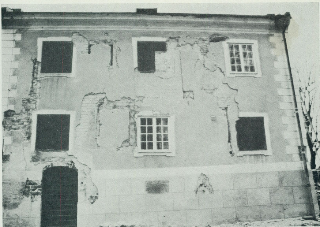
5. Köksflygelns västfasad under fasadenovering. Bomma putspartier har knackats ner och blottat murverk och fönsteröppningar från medeltid och 1600-tal. En kraftig målad dekor från 1600-talet kom fram och ses tydligast kring källardörren nederst till vänster. Skarven för klosterlängans avslutning mot norr syns strax till vänster om de båda fönsterna. Kalkmålningsfragmenten är överslammade med kalkvatten. Putsen är utlagad med kalkbruk och fasaden är avfärgad, som tidigare, i gult och vitt med återställda blindfönster i brunt och svart. Vid avfärgningen har använts enbart kalkfärg. Foto R. E.
