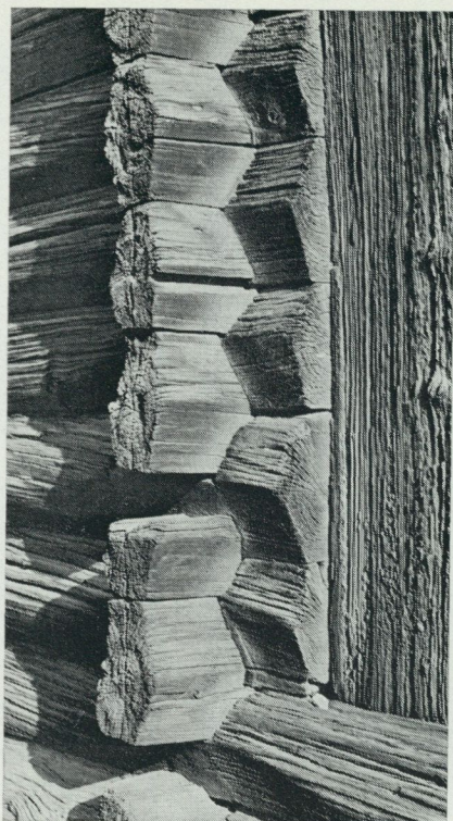
2—3. Knuttimring. T. v. Alvrosgårdens stolpbod från 1500- talet med sexkan- tiga knutskallar. T. h. ett jäbohus från Härjedalen. Båda byggnaderna på Skansen.
