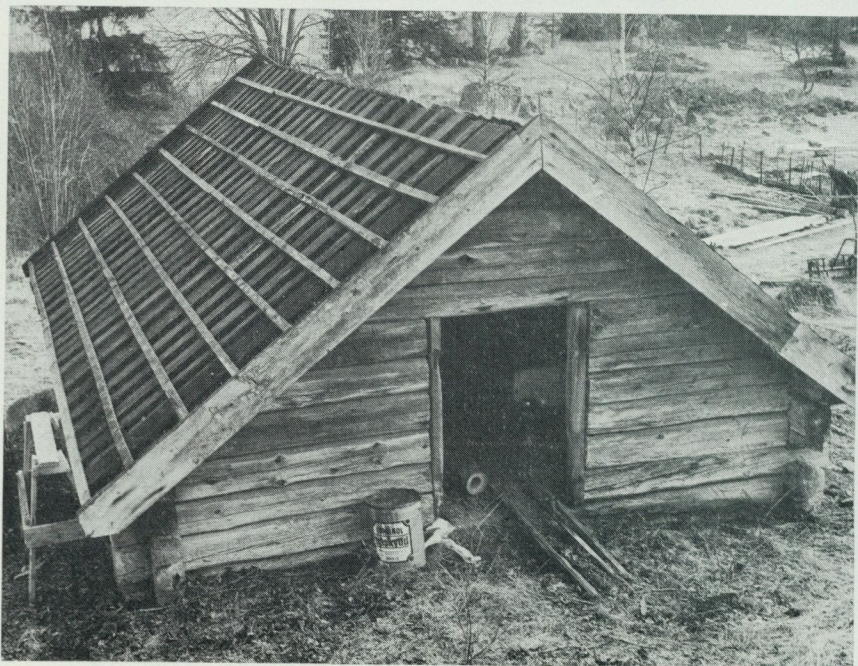
25. Djupanboda. 1600-talsloftboden under pågående reparation. Smärre partier av väggar och golv var starkt fuktskadade och har utbytt. Taket är omlagt. På den gamla panelen av mycket breda bi- lade plankor har lagts ett skikt korrugerad alumi- niumplåt. På detta lägt och tegel som tidigare.
