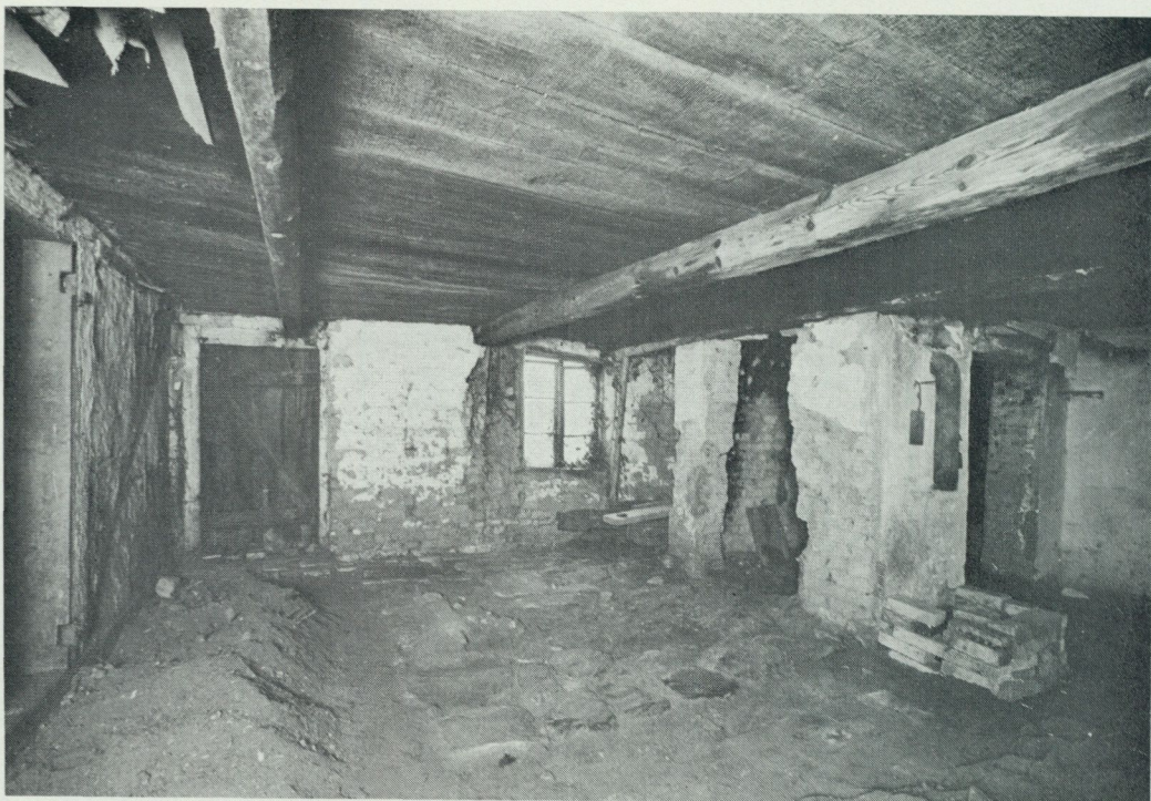
13—14. Hög 18:1. I Boningshuset finns den gamla skorstensstocken kvar, vars nedre del utgjort gårdens ursprungliga kök. Spåren efter den borttagna bakugnen är så tydliga att den kan rekonstrueras. Luckan, genom vilken biläggargugnen i stugan eldades, finns ännu kvar. Foto 1974.
