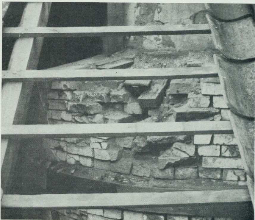
9. Kalkugnen på Julita gård från öster. Ugnen har beskicksats genom en öppning överst på denna sida. Träsigt virke och tegel har utbytts, murverk och puts har lagats, nockbråder cuprinolats, plåtskoningar utbytts. Foto J. Å.
