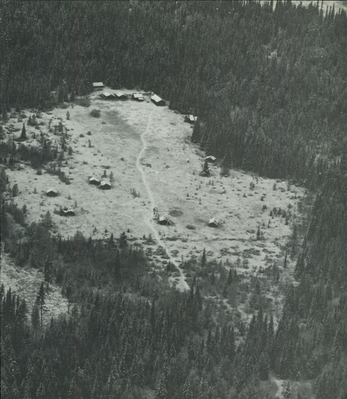
11. Skarptäkt's långfäbod i Älvdalens sn, Dalarna. En flygbild kan på ett förträffligt sätt avslöja husbeståndet på fäbodvallen. Den taklösa ladan nedtill till vänster visar ett begynnande förfall. Sedan betesgången och slåttern upphört börjar skogen tränga in på vallen. Flygfoto genom Södermanlands flygflottilj, godkänd för publicering av Försvarsstaben.
