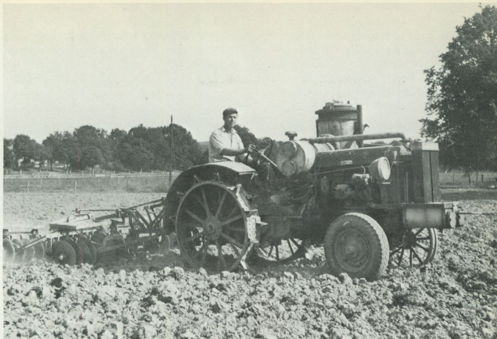
16. Traktor med gengasaggregat på Julita gård. Foto M. Lagerquist, Nordiska museet, 1944.
