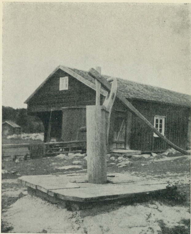
Fig. 38. Brunn med träpump. Gränsen mellan Hälsingland och Medelpad.
