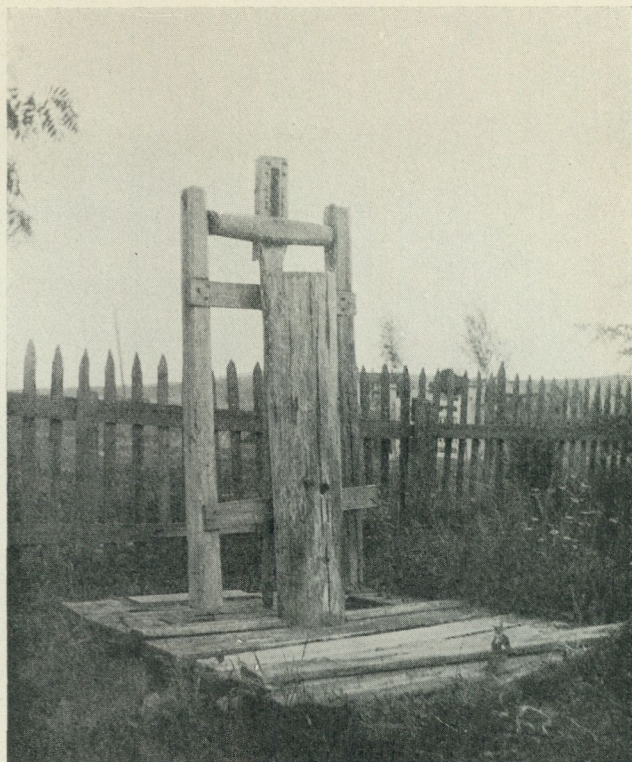
Fig. 40. Brunn med träpump. Gränsen mellan Hälsingland och Medelpad.
