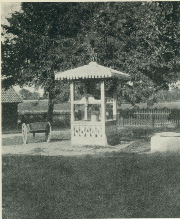
Fig. 35. Brunn med vindspel och överbyggnad. Svenska Broöns gästgivargård, Söderåkra sn, S. Möre hd, Småland. S. Exn foto 1914.
