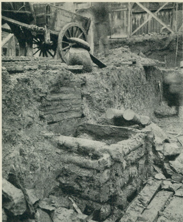
Fig. 15. Knut-timrad brunsskoning. Kvarteret Murmästaren 3, Hantverkaregatan 19, Stockholm. Foto Gösta Selling.
