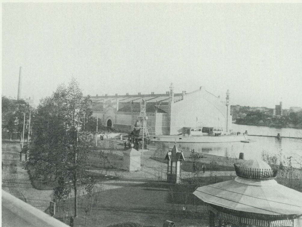
Maskinhallen sedd från centralrestaurangens takterrass. I bakgrunden skorstenen till utställningens ångpannecentral vid Allmänna gränd. Utställningen hade flera åttkantiga kiosker som den i mellangrunden. En av dem finns numera på Skansen. Foto Axel Lindahls ateljé.
