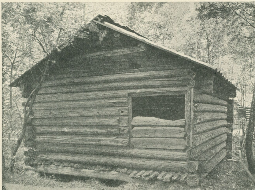
Fig. 21. Hölada från Medle i Västerbotten. Återuppförd på Skansen.
